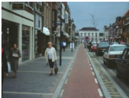
Fietspad in kleinschalige elementen
