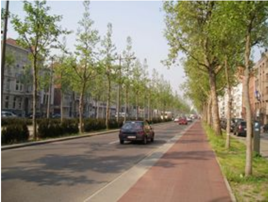
Fietspad in asfalt
