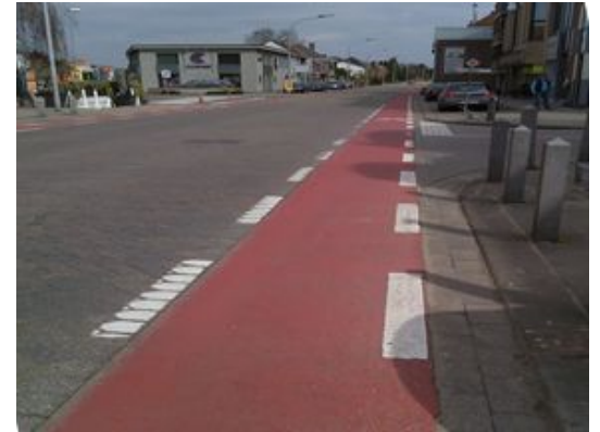
Fietspad in dunne toplaag
