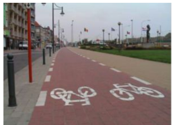
Fietspad in kleinschalige elementen
