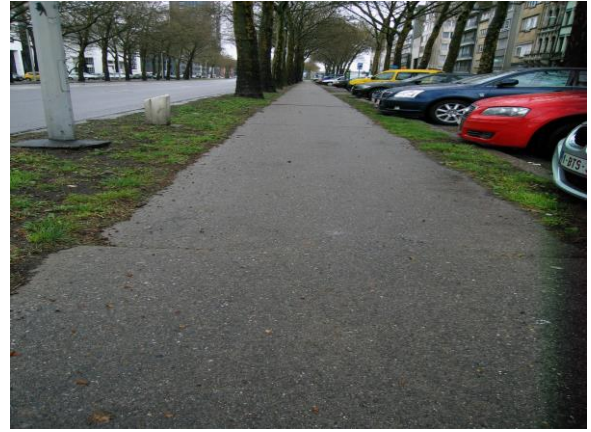
Fietspad in platenbeton
