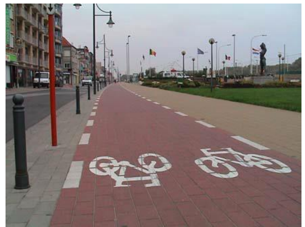
Fietspad in kleinschalige elementen
