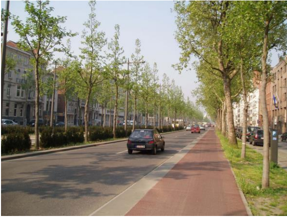
Fietspad in asfalt
