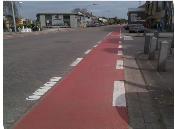
Fietspad in dunne toplaag
