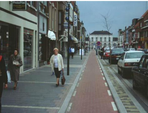
Fietspad in kleinschalige elementen
