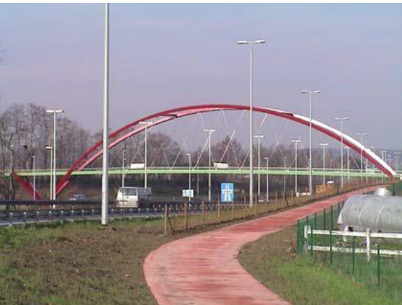
Fietspad in doorgaand gewapend beton
