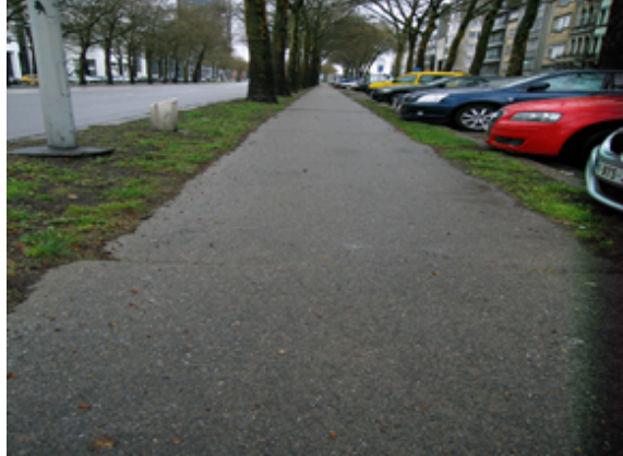
Fietspad in platenbeton
