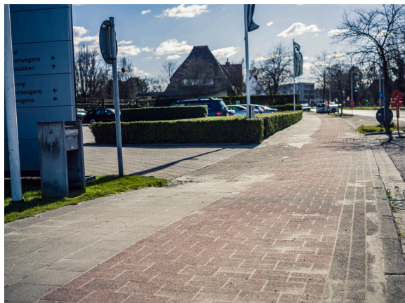
Fietspad in kleinschalige elementen
