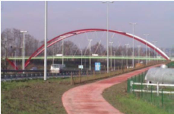
Fietspad in doorgaand gewapend beton
