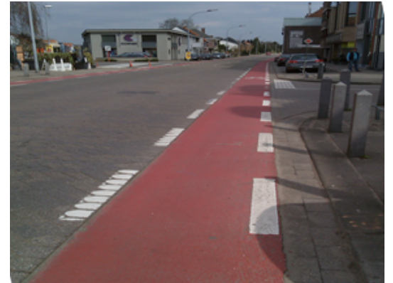
Fietspad in dunne toplaag
