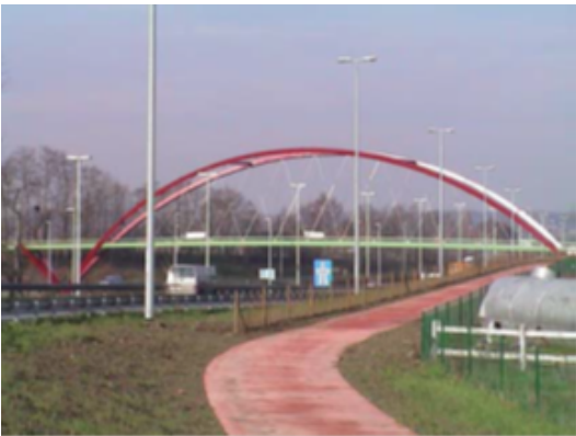
Fietspad in doorgaand gewapend beton
