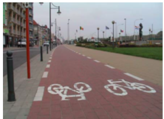
Fietspad in kleinschalige elementen
