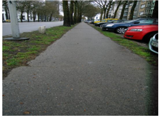
Fietspad in platenbeton
