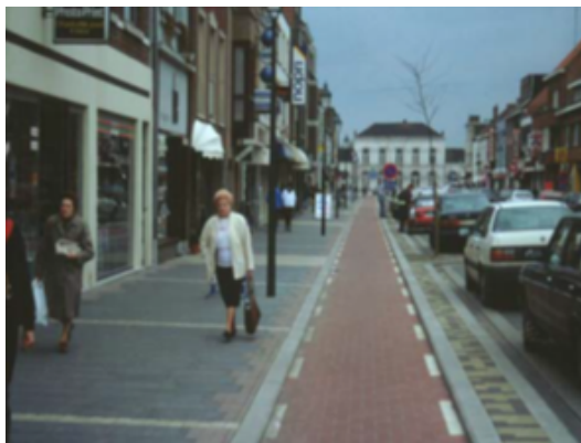
Fietspad in kleinschalige elementen
