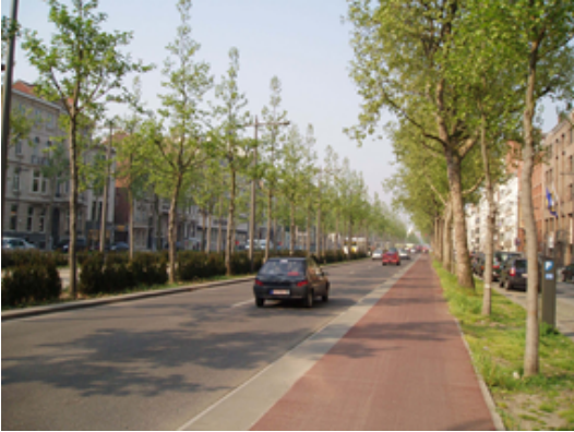
Fietspad in asfalt
