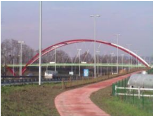
Fietspad in doorgaand gewapend beton
