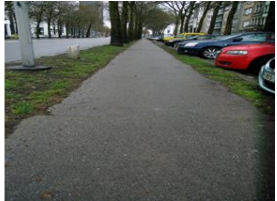
Fietspad in platenbeton
